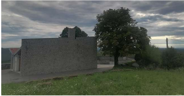
Edificio della camera mortuaria
