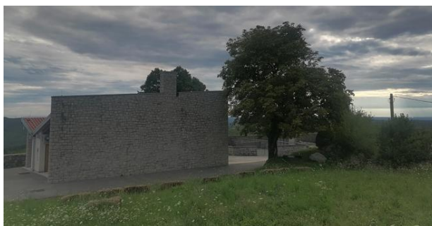
Edificio della camera mortuaria
