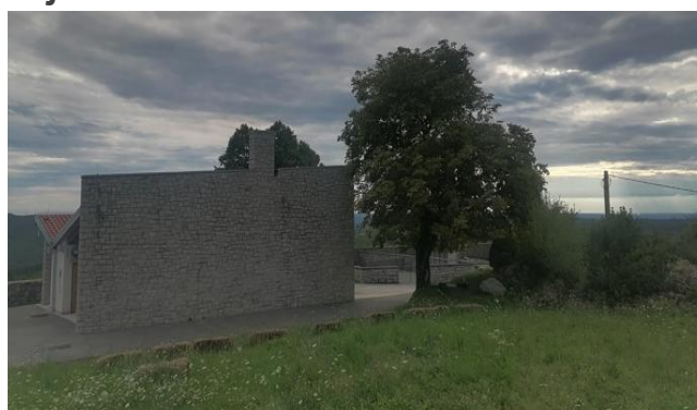
Stavba mrliške vežice
