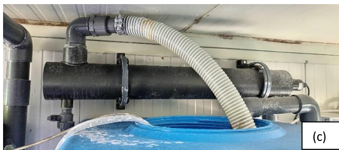
Slika 1: (a) LED luči, (b) vodna črpalka za eno linijo, (c) namestitev UV filtra
