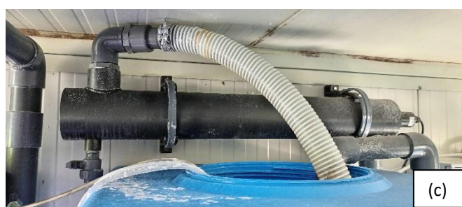
Figure 1: (a) Luci LED, (b) Pompa di acqua per una linea, (c) Montaggio del Filtro UV
