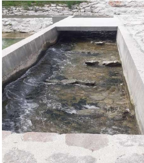
Figura 6: Tratto a più a monte con portate ottimali per la funzionalità della scala.
