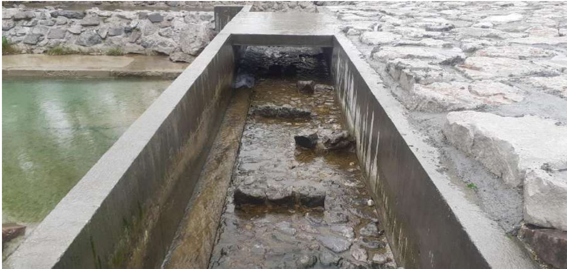
Figura 4: Tratto a più a monte con portate al limite della funzionalità della scala.
