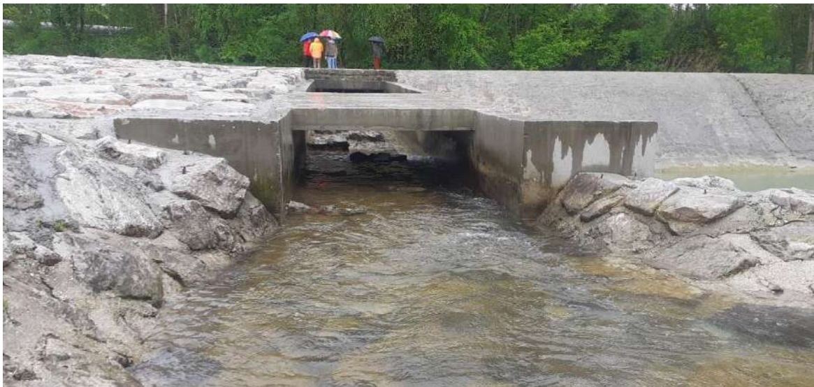
Figura 5: Tratto intermedio con portate al limite della funzionalità della scala.
