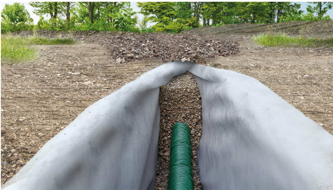
Schema 4: Corretta realizzazione del sistema di drenaggio (Studio Podobarna)
