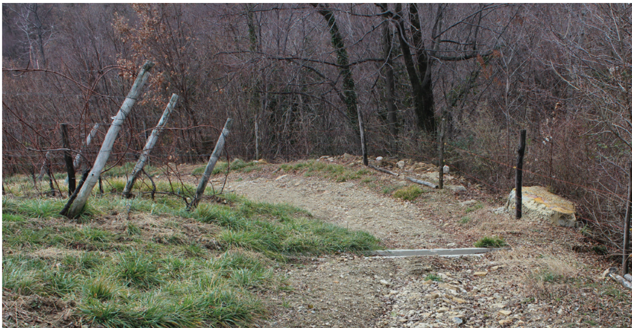
Figura 13: Area di manovra con drenaggio sistemato (foto: archivio KGZ Nova Gorica)
