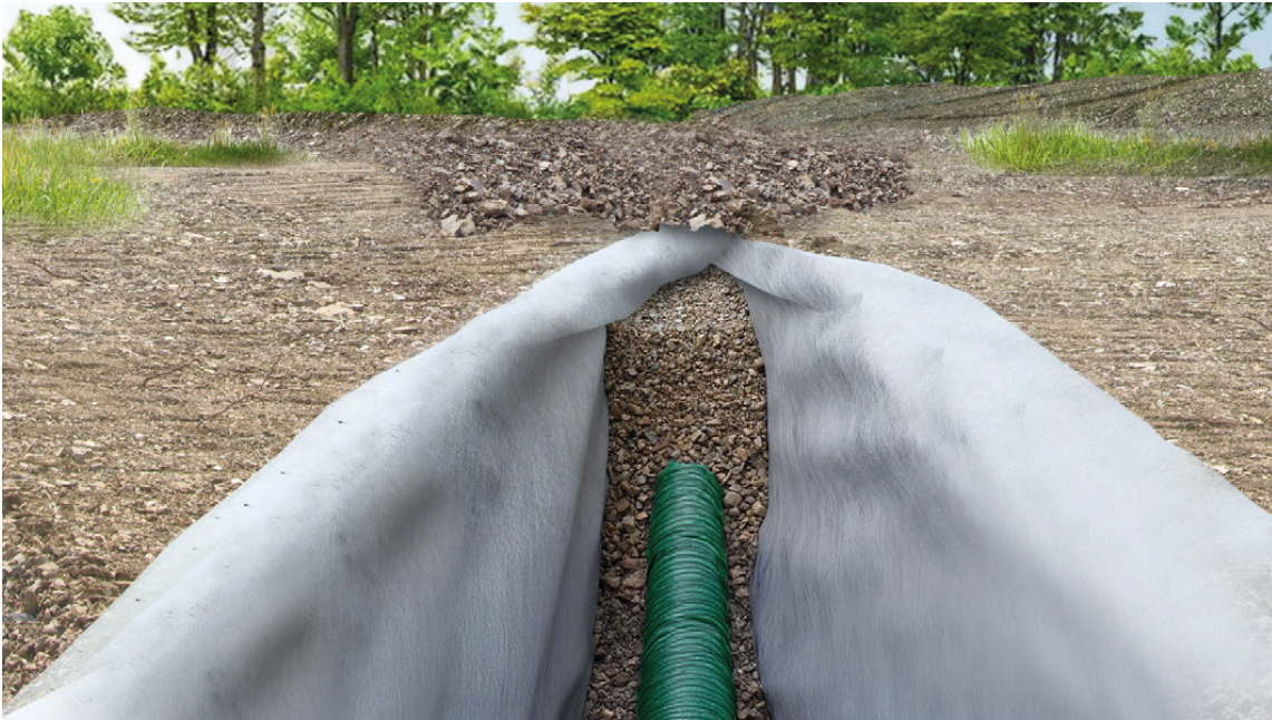
Shema 4: Pravilna izgradnja drenažnega sistema (Studio Podobarna)
