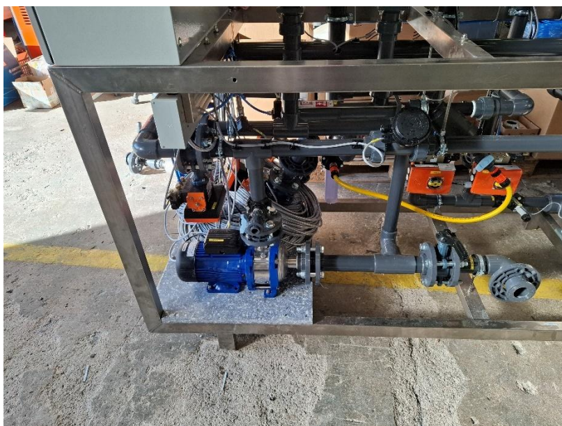
RECIKLIRANA FRC PLOŠČA, UPORABLJENA KOT PLATFORMA ZA VODNO ČRPALKO
