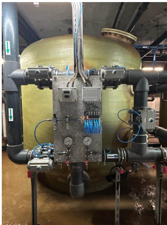
MONTAŽA PLOŠČE V STROJNI SOBI OBČINSKEGA BAZENA
