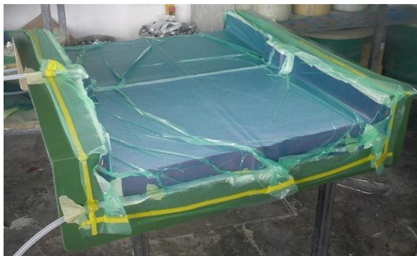
Figura 3b: Preparazione della piastra in CFR semplice mediante stampaggio con sacco da vuoto (fonte: documentazione fotografica interna TECHNOL).
