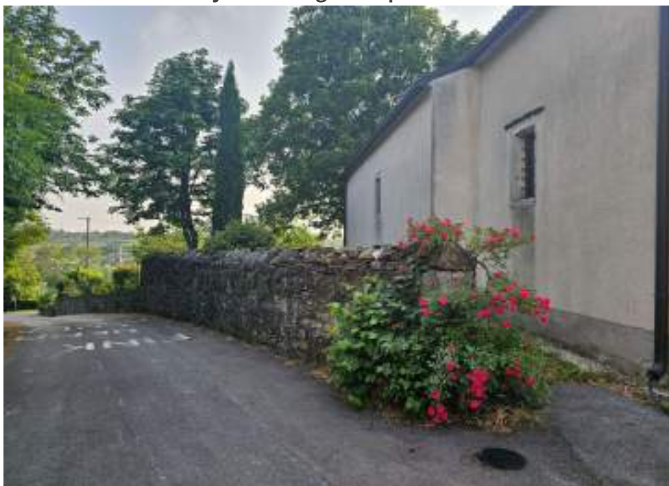
Stanje kamnitega zidu pred obnovo
