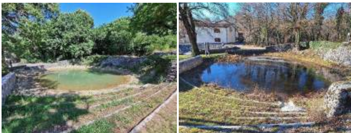
Brežec dopo il restauro del 2021 e del maggio 2024
