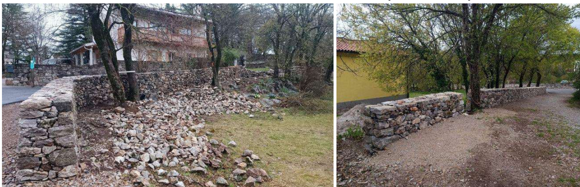
Muretto a secco restaurato – ENGREEN (febbraio 2025)
