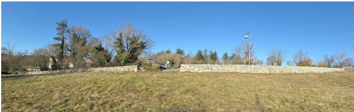
Muretto a secco restaurato – ENGREEN (marzo 2022)
