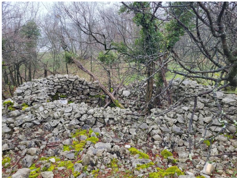
Figura 20 – Edificio 10 da Figura 9.
