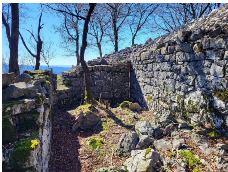
Figura 23 – Edificio 12 da Figura 9.
