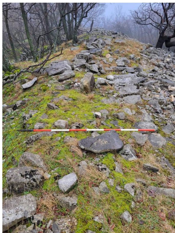
Figura 21 – Rielaborazione post-protostorica del muro difensivo con costruzione in malta (per la posizione vedi Figura 9, n. 11).
