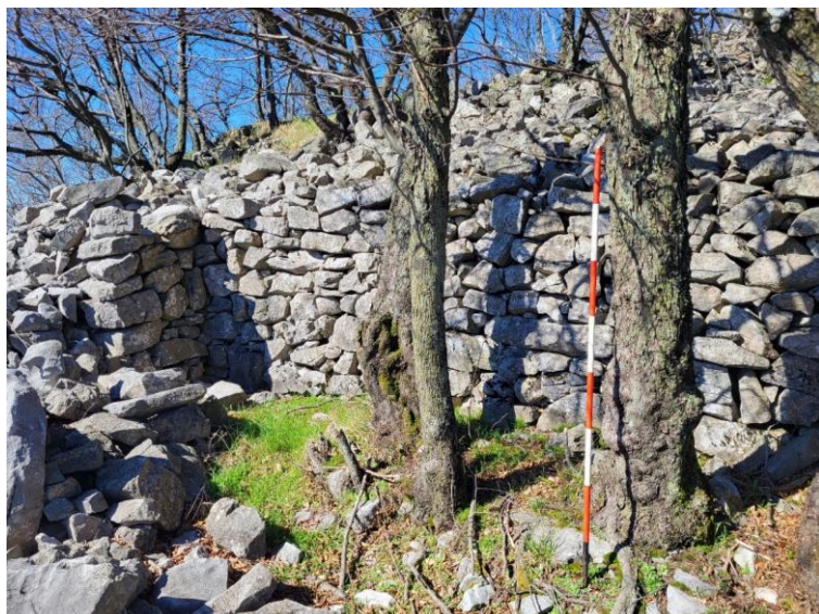
Figura 22 – Edificio 13 da Figura 9.
