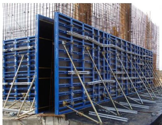
Figure 4: Opaž iz kovine in vezane plošče ( www.ceta.it )
